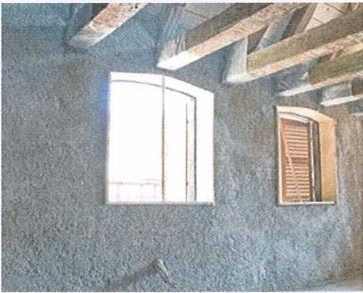
Exemple béton de chanvre Pour isolation mur mitoyen grange
