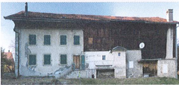
Façade sud-est, côté campagne
